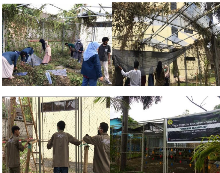
Gambar 1 Proses pembuatan Rumah Paranet pembibitan
