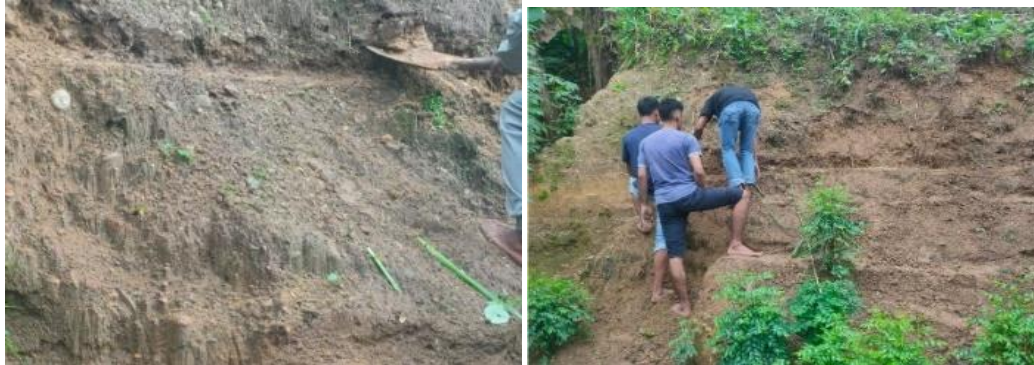
Gambar 7 Pekerjaan sistem teras pada lereng
