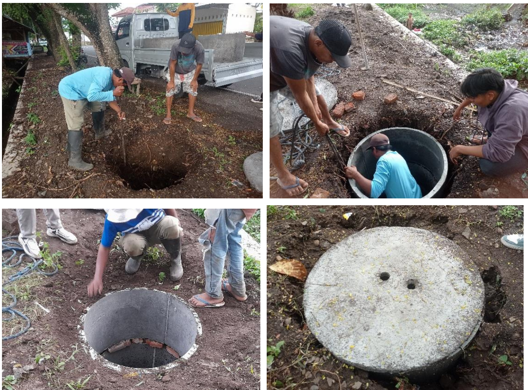
Gambar 4. Pembuatan sumur resapan
