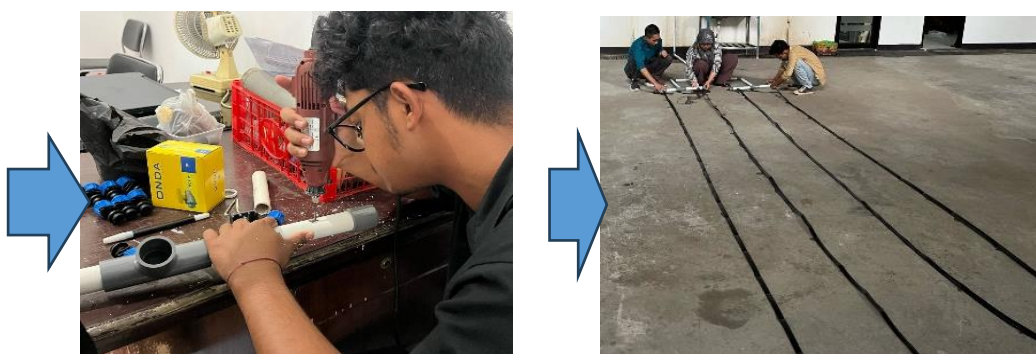
Gambar 2. Persiapan jaringan distribusi dan koneksi jaringan tetes
