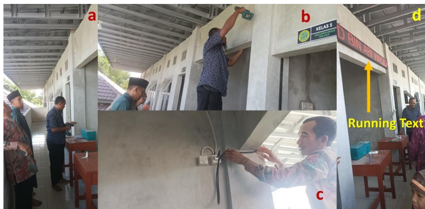
Gambar 8. Proses pemasangan running text
