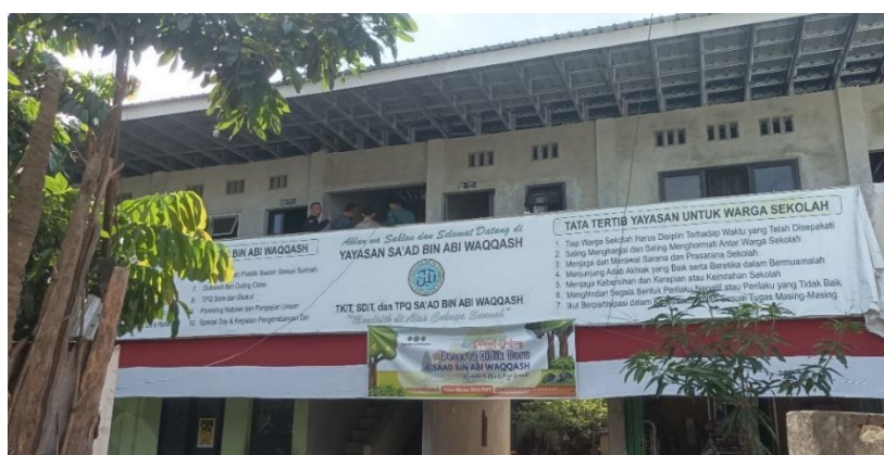
Gambar 2. Tampak depan Gedung SDIT Saad Bin Abi Waqqash
