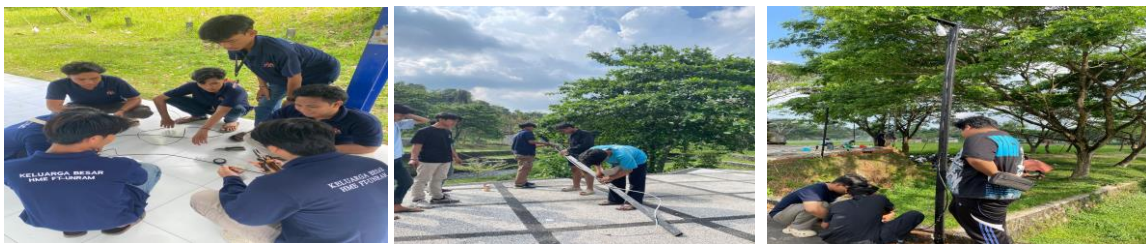
Gambar 2. Proses Pemasangan Instalasi Listrik.
